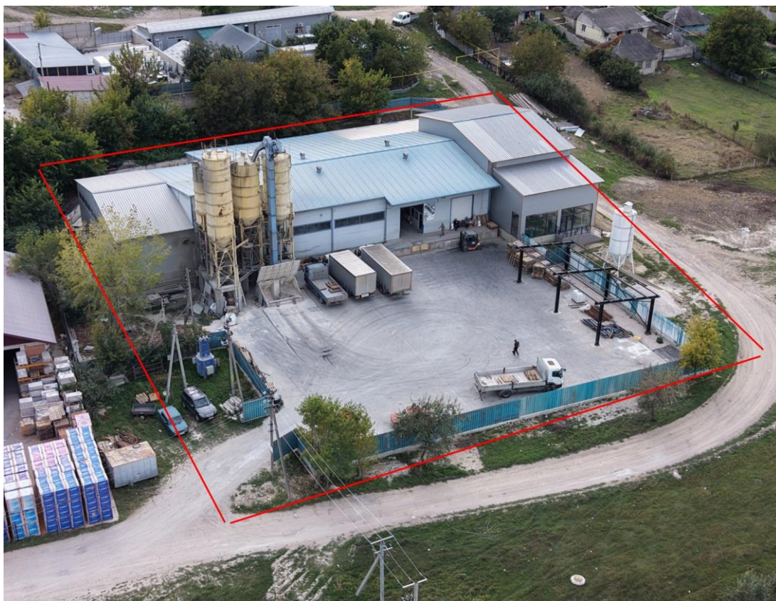
Foto 1. Grătiești, str. Miron Costin 29 (nr. cad. 0155213.126) – vedere de sus; conturul imobilului marcat cu linie roșie. Se observă silozurile și linia de producere a mortarelor uscate exploatare de SRL „General Building”.
